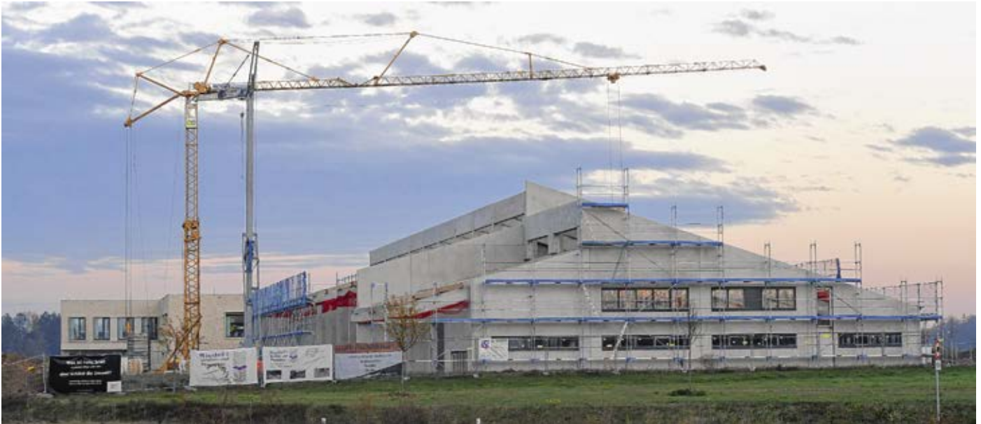
Das Wertstoffzentrum im Rohbau
